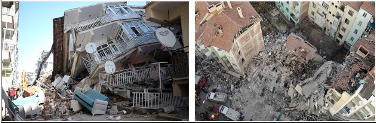
Görsel 1. 2020 Elazığ depremi sonrası yıkılan binalar
